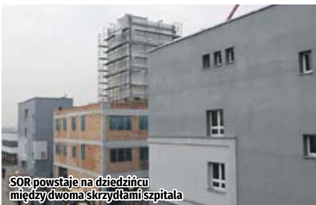
Prace budowlane ruszyły w czerwcu tego roku
