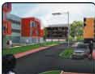
Gliwice - nowoczesne osiedle w trakcie realizacji. Mieszkania 1,2,3 i 4-pokojowe. Budynki 2-piętrowe z windą. Promocyjne ceny
