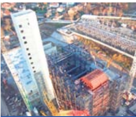
Trwa budowa elektrociepłowni Fortum
