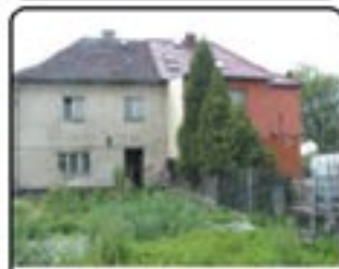
Droga wlotowa do Gliwic - dom w zabudowie bliźniaczej o powierzchni 120 mkw. Działka 850 mkw. Remont Kapitałny. Cena: 180.000 zł
