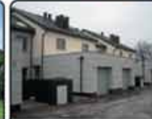
Knurów okol Inbermarche - dom w zabudowie szeregowej. Pow 179 mkw, działka 237 mkw. Instalacje, wyłoki, piec CO. Proponowana cena: 535.000 zł
