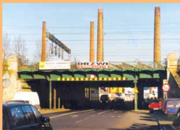
Wiadukt przy ul. Piwnej 20 lat temu...
