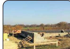
Zabrze Rokitnica. Rozpoczęta budowa domu o powierzchni 144m. Powierzchnia działki 750mkw. Proponowana cena: 385.000 zł
