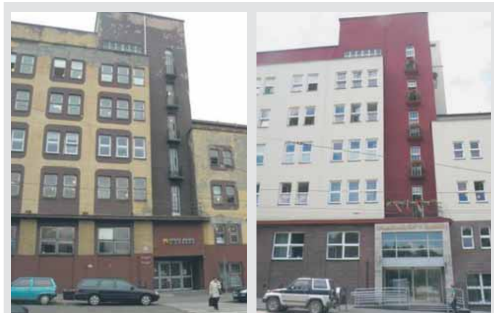
Elewacja budynku Urzędu Miejskiego przed remontem...
